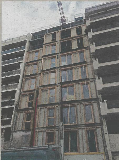
▲ Les façades en béton de chanvre n'ont pas encore été projetées, laissant apparaître la structure secondaire en bois et les planchers en béton classique.
