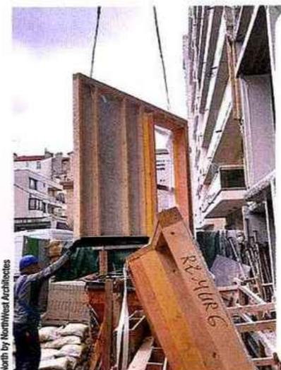
Préfabriqués en atelier par Meha Charpentes pour optimiser la logistique du chantier, les panneaux ossature bois sont fixés à la structure porteuse en béton. De 3 à 4 m de largeur sur 2,5 m de hauteur, ils sont clos par des plaques Fermacell qui servent à la fois de finition intérieure et de fond de coffrage pour le béton de chanvre.
