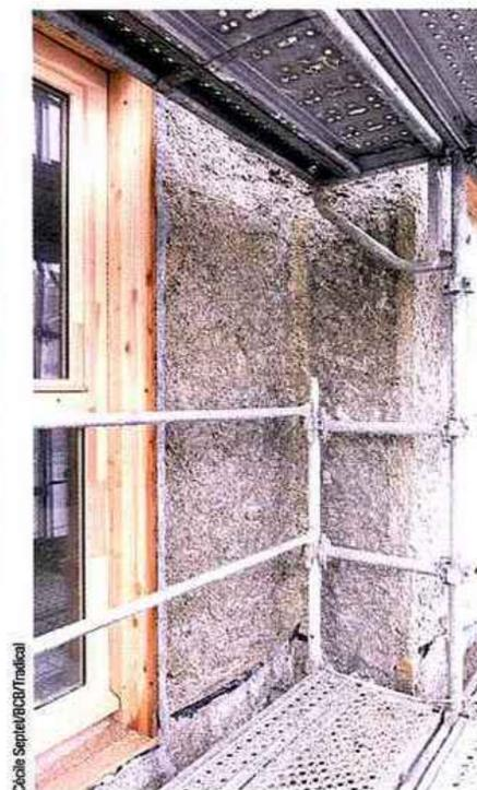
La chènevotte et la chaux sont acheminées par deux tuyaux de 50 m. Le mélange, qui s'effectue dans la lance, est projeté sur 22 cm d'épaisseur (pour une épaisseur totale de façade de 26 cm), puis dressé à la règle. En tout, 60 m<sup>3</sup> de béton de chanvre ont été mis en œuvre en deux semaines sur les deux façades. Après séchage, elles seront recouvertes d'un enduit chaux Tradical PF 80 + sable.
