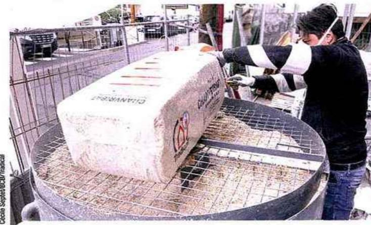
Constitué d'un mélange de chaux Tradical Thermo et de chènevotte Chanvribat, le béton de chanvre est réalisé sur site et mis en œuvre par une équipe de 6 compagnons de JR Bat, formés à son application. Les malaxeurs de chènevotte et de chaux sont installés au pied de la façade rue.
