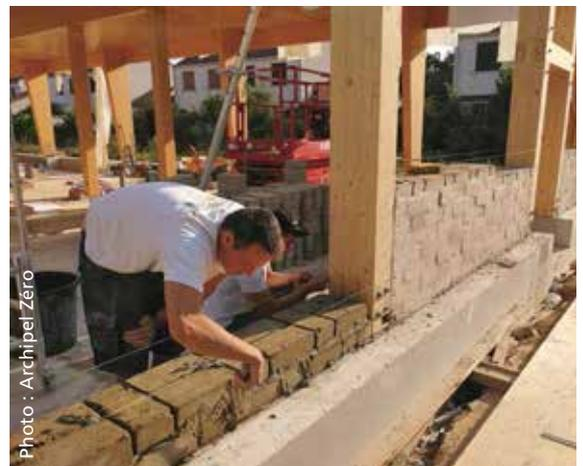
▲ Le mur Trombe construit en brique de terre crue.
