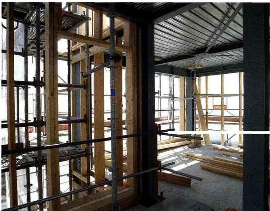
L'ossature bois du béton de chanvre projeté est positionnée à l'extérieur de la structure acier.
