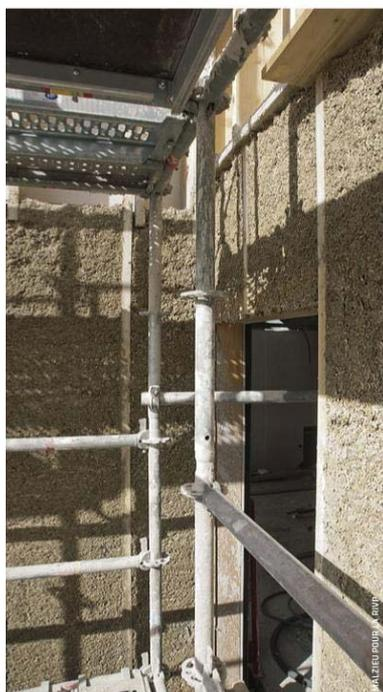
Compatible avec l'acier de la structure primaire du bâtiment, le béton de chanvre est amené à pied d'œuvre et directement projeté par une machine spécifique. Le mélange entre la chaux et la chènevotte s'effectue dans la lance lors de la projection afin d'assurer une répartition homogène des matériaux. La porosité des revêtements de finition permet de tirer avantage de l'hygroscopie du produit.
